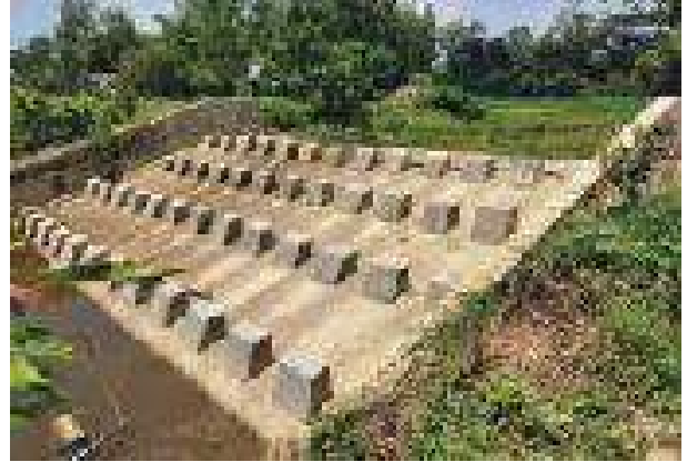
Figure 3: মরাছড়া খালে Baffled Apron drop
