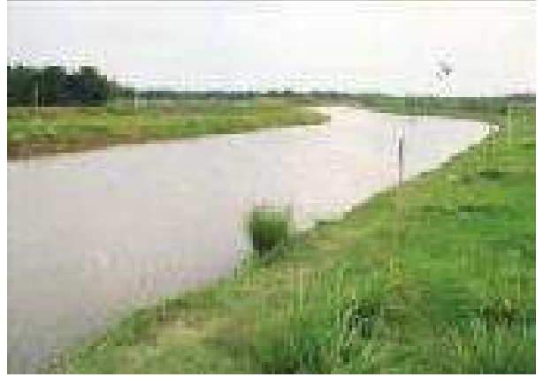
সিলেট জেলার বালাগঞ্জ উপজেলাধীন বড়বাঘা নদী পুনঃখনন পরবর্তী কাজের স্থিরচিত্র।
