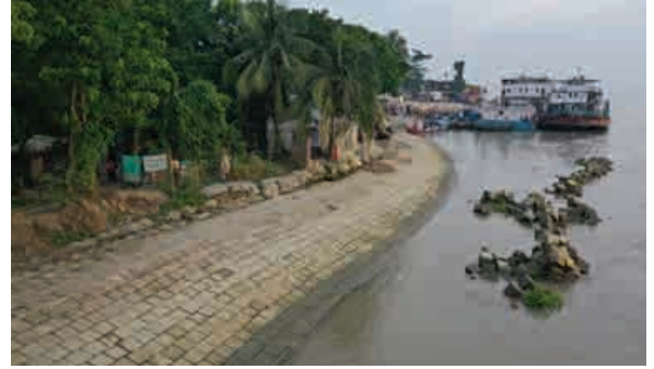
মেঘনা নদীর ভাঙ্গন হতে হরিণা ফেরীঘাট এলাকা এবং চরভৈরবী এলাকার কাটাখাল বাজার রক্ষা প্রকল্প, চাঁদপুর।
