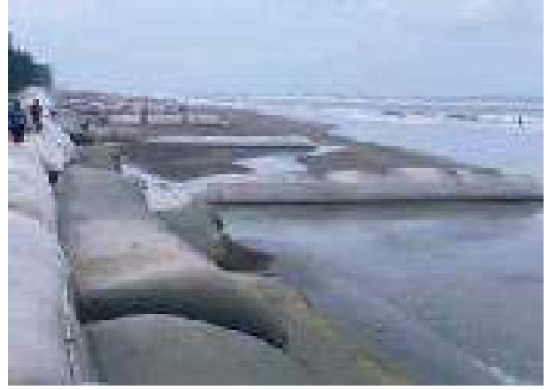
Figure 2: সী-বীচ, কক্সবাজার, Wave Breaker/Silt trap
